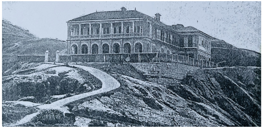
Das Blindenheim in Kowloon nach dem Anbau 1906
